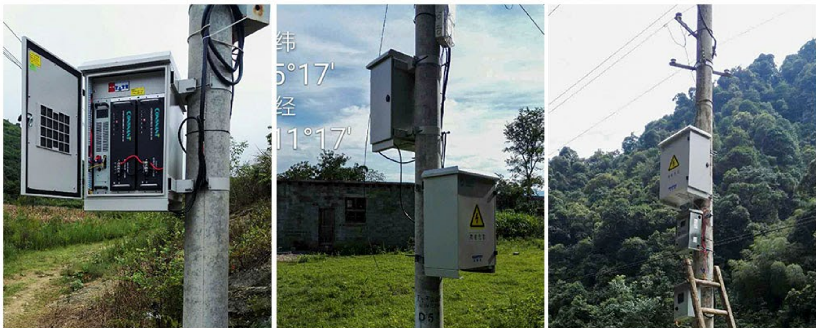
地点: 中国永州市 项目: 室外不间断电源 2KVA, 内置 2 块 51.2VDC 50Ah 锂电池组, 以及室外不间断电源 1KVA, 内置 1 块 51.2VDC 50Ah 电池; 中国移动项目。
