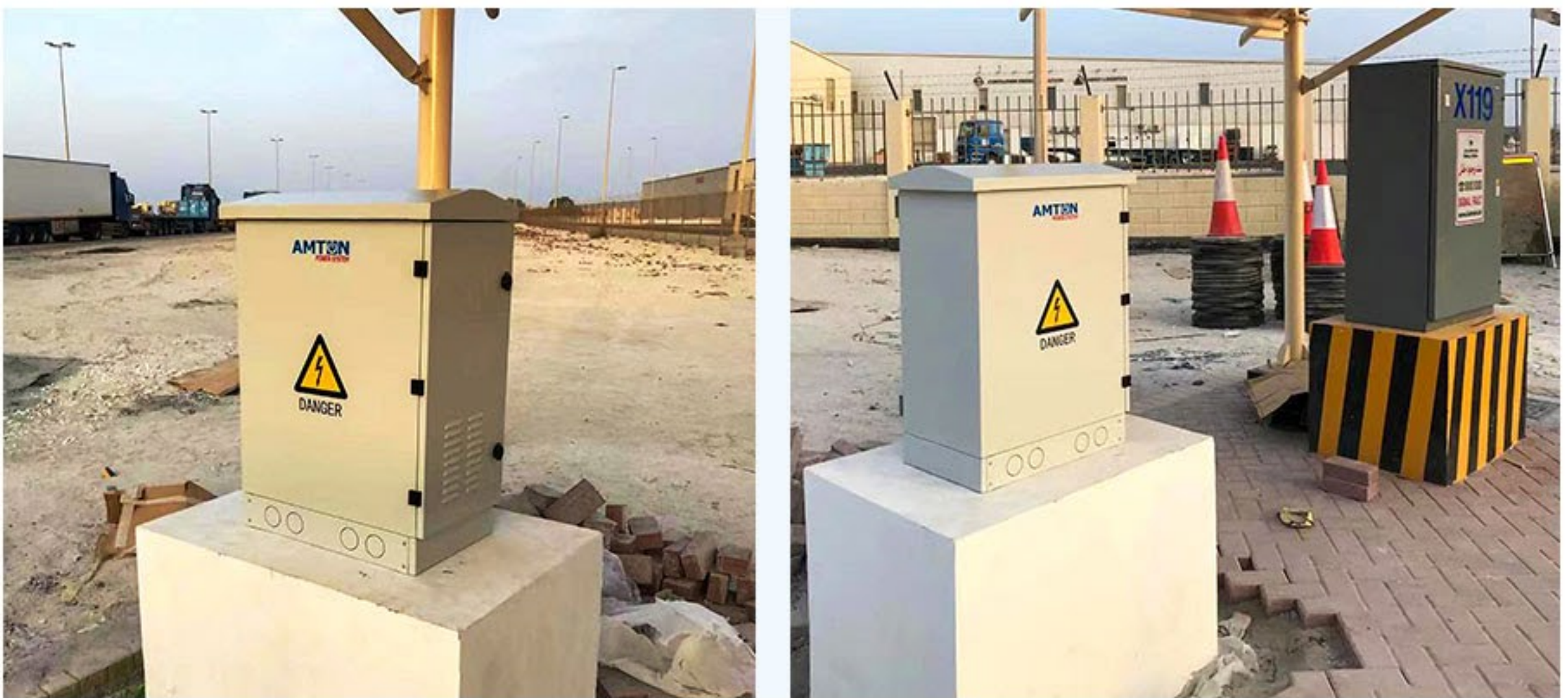
地点: 巴林 项目: 2KVA 户外不间断电源, 内置 51.2VDC 100Ah 锂电池。
