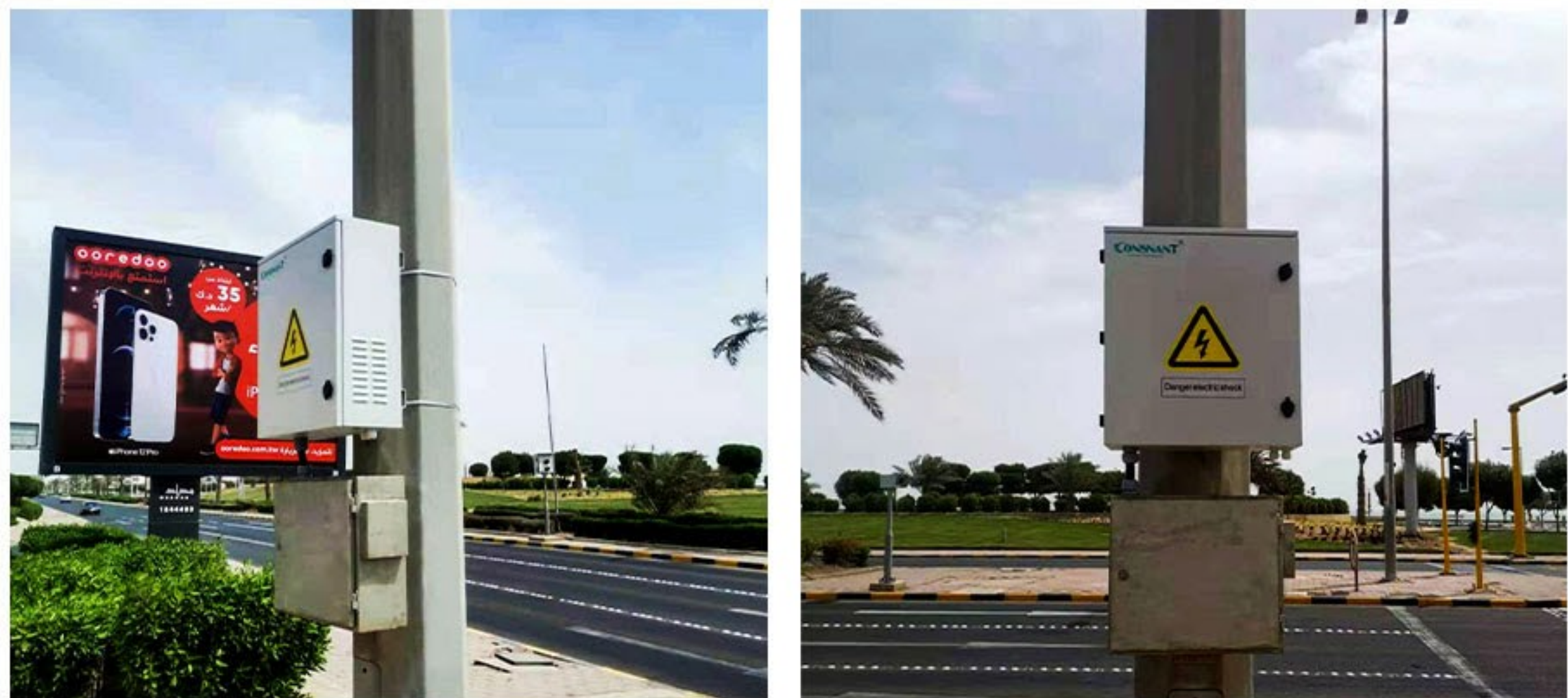
地点: 科威特 项目: 户外UPS1KVA, 内置电池 12VDC 9AH x 3 个, 适用于交通灯和闭路电视摄像机。
